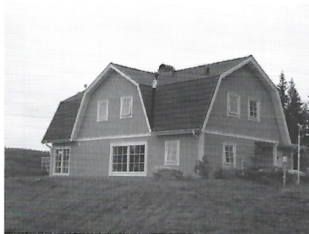
Övre Lerbråten efter ombyggnaden 2008.
