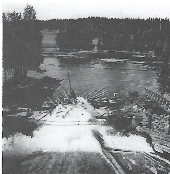
Ovan: Timmerbråte i Vårforsens utlopp i Bjälven vid Sälboda såg. Här fick man spränga loss timret med hjälp av dynamit.
