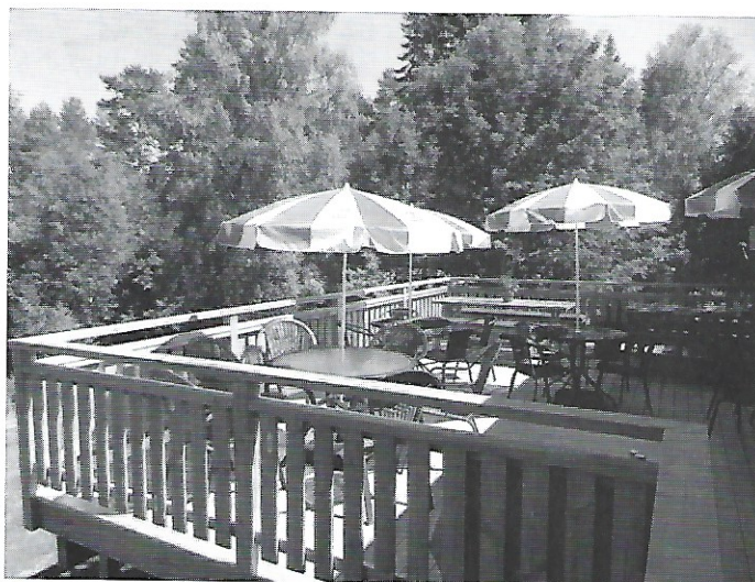
Den nybyggda terrassen vid Tvällens Vårdshus
