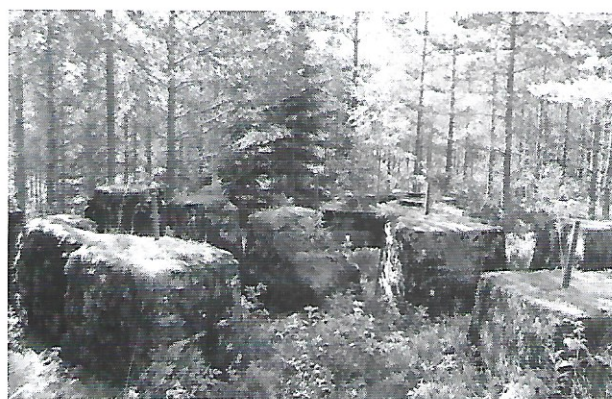
Ett minnesmärke - fundamentet till drivstationen vid Bytorp
