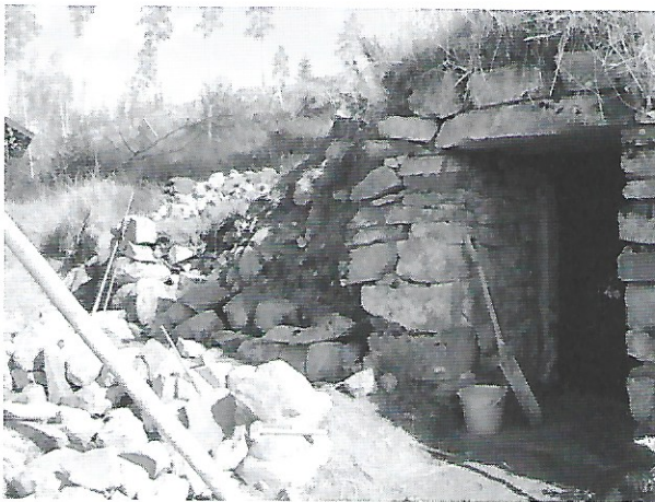
Jordkällare av typen överliggande stenhäll under renovering.
