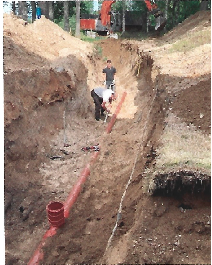
Byte av avloppsrör
